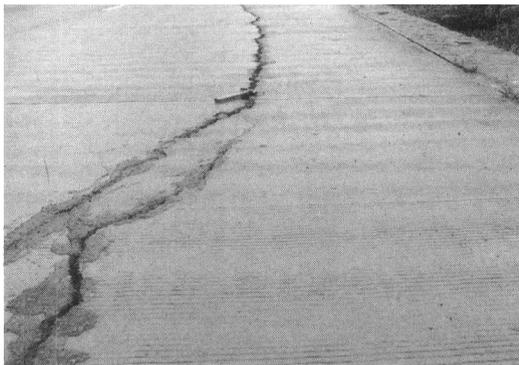
图2 滑坡后缘公路拉裂破坏
